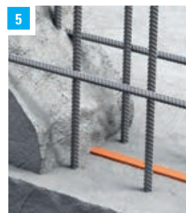
5 Zabetonowana taśma MC-Quell SW
